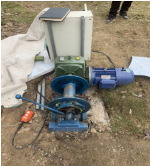
图3“卷扬机”及控制箱安装形貌
